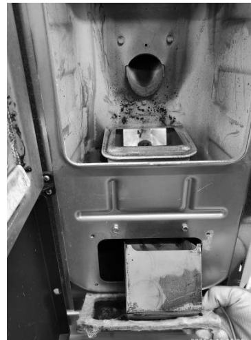
Fig. 76 - Retirer le bouchon d'inspection
